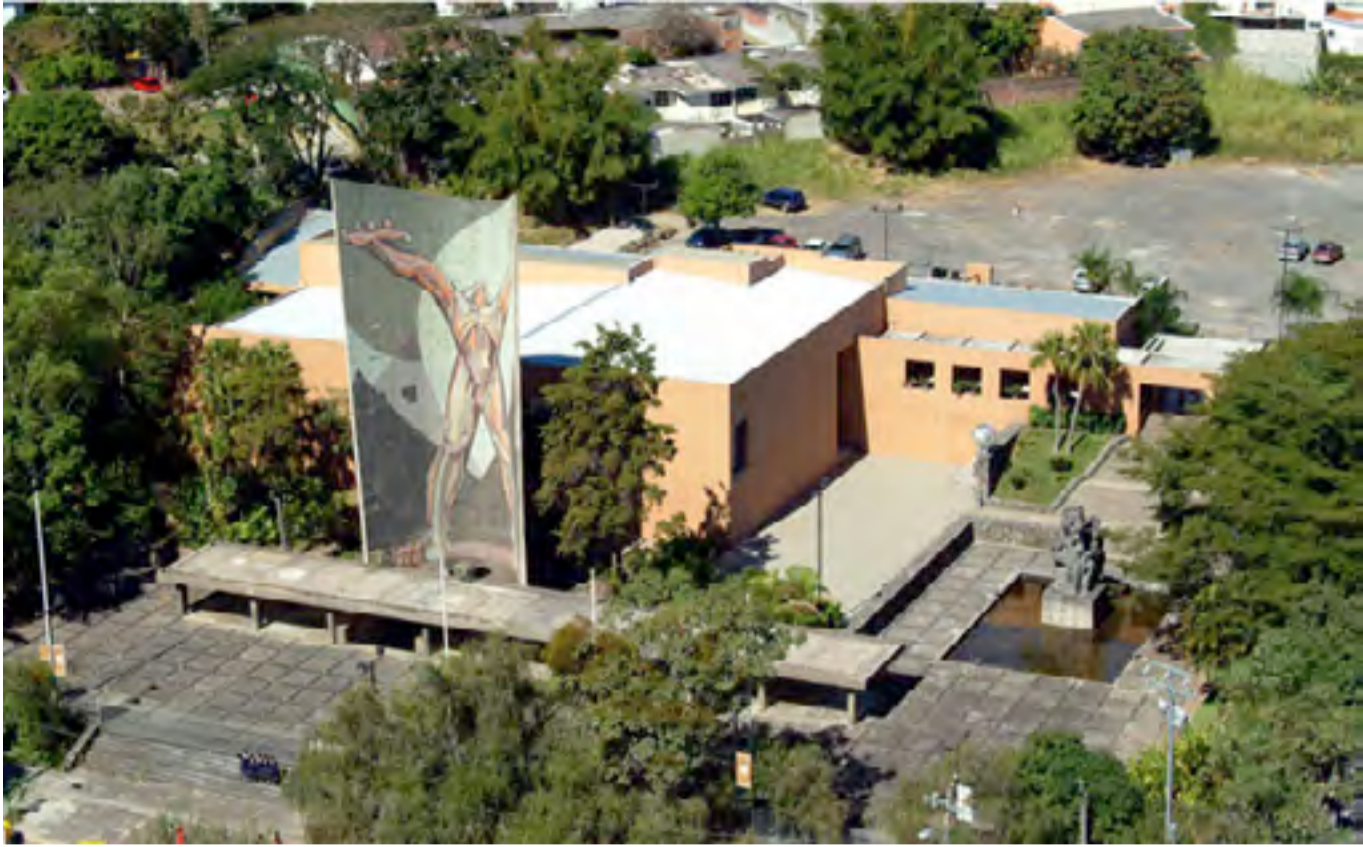
87. Arq. Salvador Choussy (1947) Edificio del Museo de Arte de El Salvador (MARTE), 2003 Final avenida La Revolución, colonia San Benito
